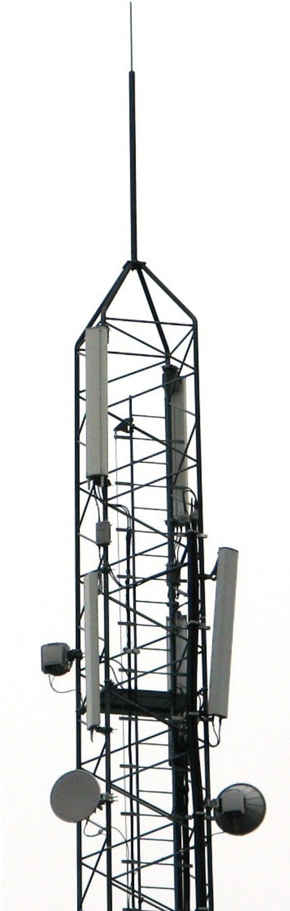
Gittermast med flere antenner
